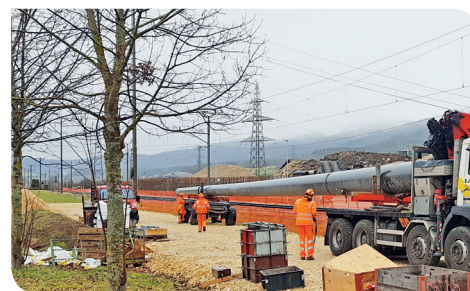
Transport des mâts sur le chantier
